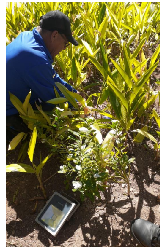
Cambio reflector dañado caseta El Petén
