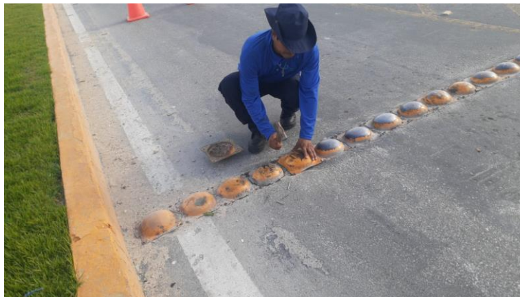
Se coloca boya faltante en carril de desaceleración
