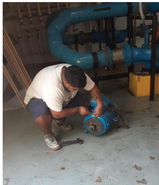
Mantenimiento preventivo a bombas de cascadas
